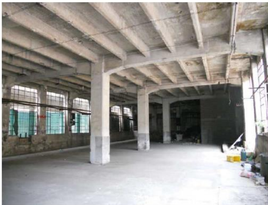
Struttura al piano terra (piano cortile)
