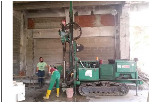
Sondaggio S2 (12 m)
